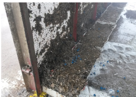
Рис. 2. Рештки відмерлих організмів на гідротехнічних спорудах СТВ (АЕС Козлодуй)
