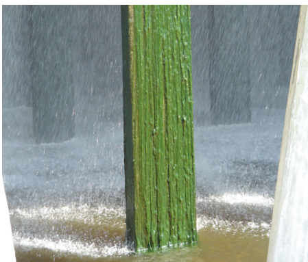
Рис. 3. Плівка водоростей на опірах градирні (АЕС Моховце)
